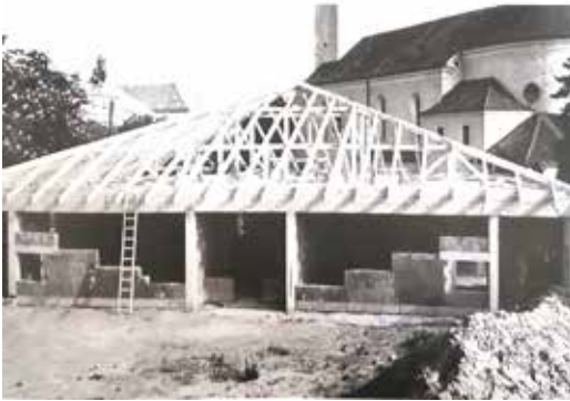
Bild der Baustelle gartenseitig aus der Festschrift zum Neubau
