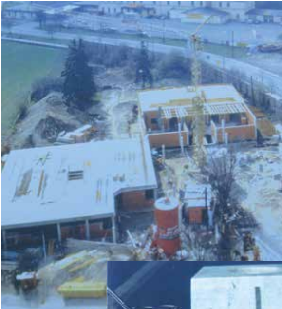
Luftansicht während dem Bau des Pfarrzentrums
