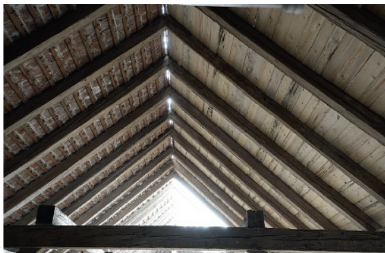
Bild mit alter (links) und neuer (rechts) Dachlattung
